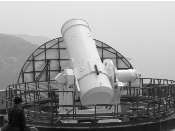
图 5 安装完成的阻导风板 Fig. 5 The installed H-G windscreen
